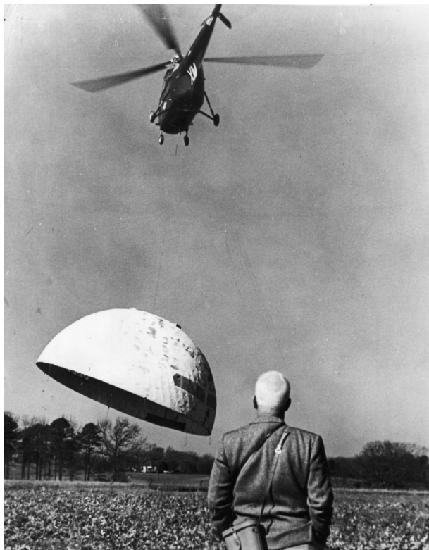
Fuller presencia cómo un helicóptero de la Marina eleva su cúpula geodésica en Orphan's Hill, 1954.
